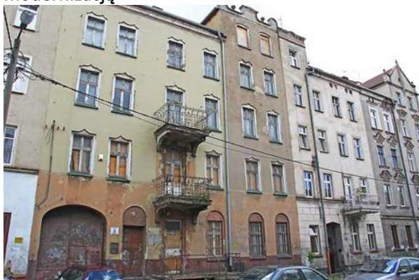
Budynek przy ul. Kościelnej 3 – przed modernizacją
