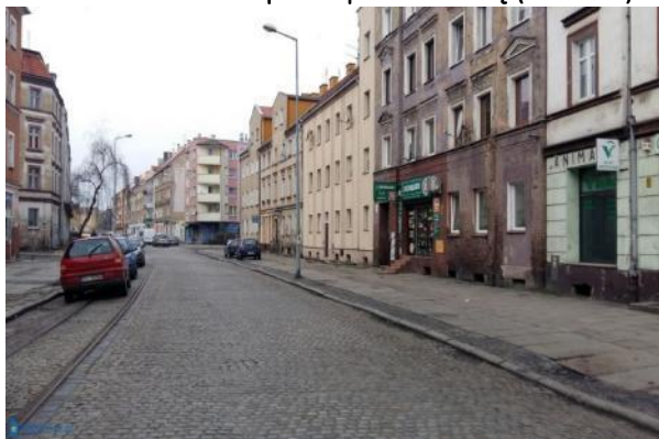
Ulica Wrocławska – przed przebudową (fot. UM)
