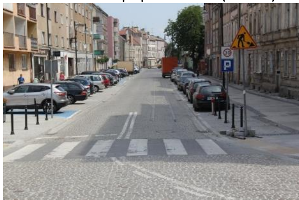
Ulica Wrocławska – po przebudowie (fot. UM)
