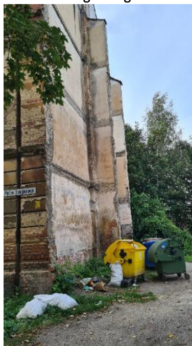
Elewacja i otoczenie jednego z budynków przy ul. Księdza Piotra Ściegiennego
