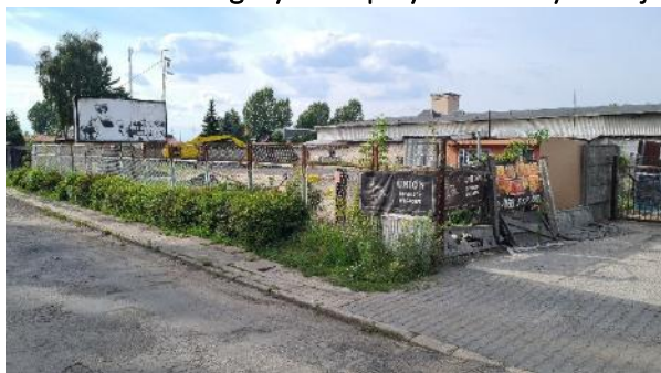
Zabudowania magazynowe przy ul. Przemysłowej
