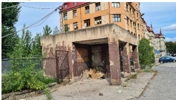
Ruina budynku przy ul. Kardynała Bolesława Kominka
