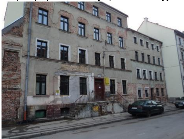
Budynek przy ul. Kamiennej 6 przed renowacją
