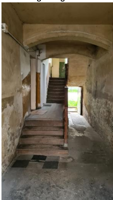
Klatka schodowa jednego z budynków przy ul. Księdza Piotra Ściegiennego
