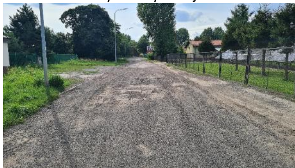
Nawierzchnia ulicy Przemysłowej
