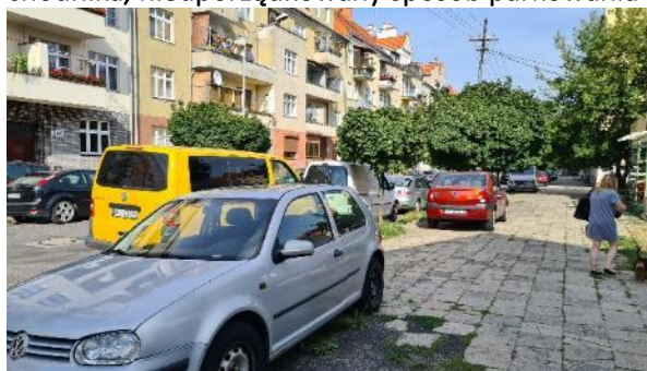
Ulica Żwirki i Wigury, zły stan nawierzchni chodnika, nieuporządkowany sposób parkowania
