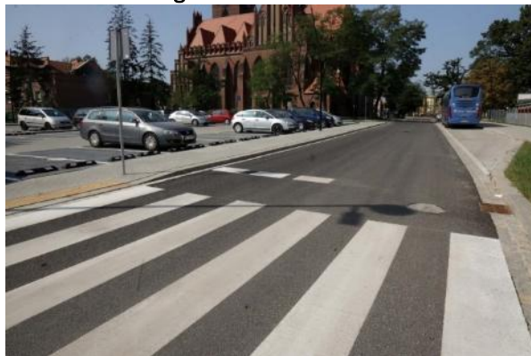
Zmodernizowana infrastruktura drogowa w ciągu ul. Limanowskiego
