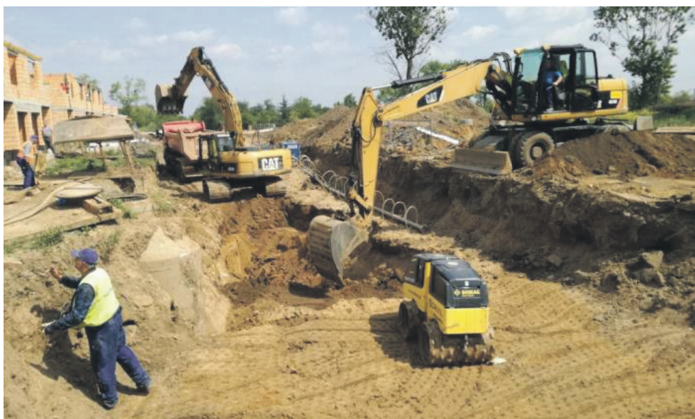
Budowa ulicy Tadeusza Gumińskiego. FOT. UM Legnica.
